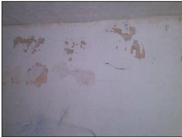
Fig. 37 MINADO DE AGUA EN MUROS
