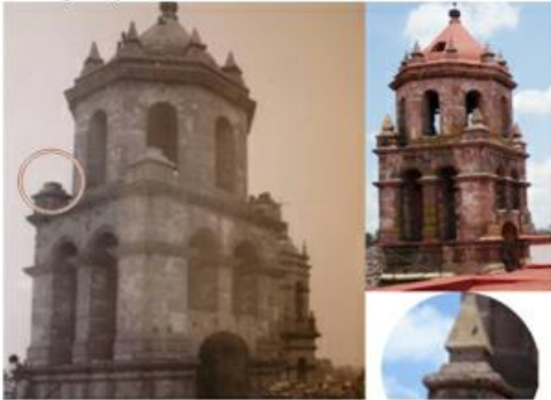
Ilustración 33. Restauración e impermeabilización en ventanas de cúpula. Antes y después.
