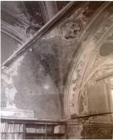
Ilustración 38. Reparación de humedad en muro, y restauración en faltantes de molduras y capa pictórica.
