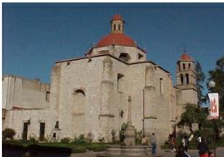
Ilustración 13. Fachada poniente de la Biblioteca Pública.
