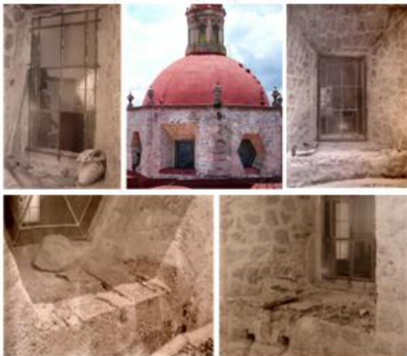
Ilustración 33. Restauración e impermeabilización en ventanas de cúpula. Antes y después.
