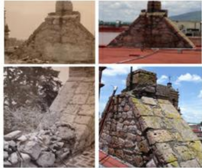
Ilustración 36. Reparación de fractura e impermeabilización en enladrillado de azotea, gárgolas y pretilas.
