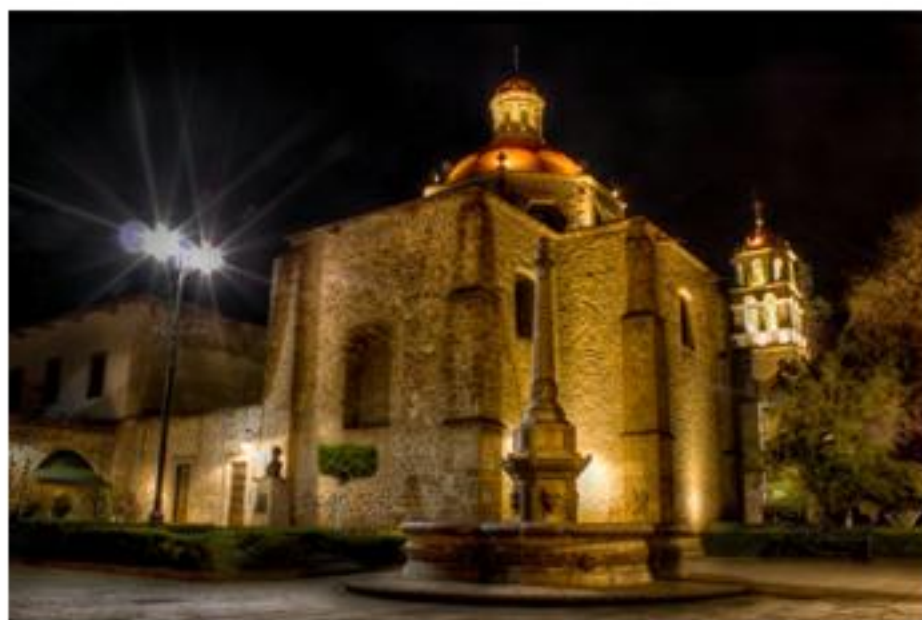
Ilustración 42. Imágenes sobre la iluminación decorativa nocturna en el edificio de la Biblioteca Pública Universitaria y en el jardín Ignacio Manuel Altamirano.
