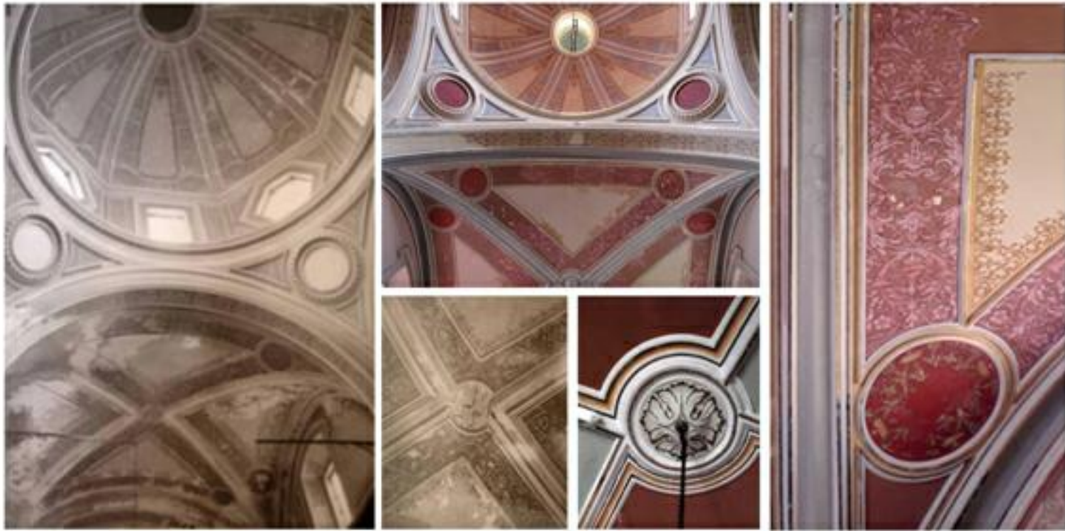
Ilustración 41. Reparación estructural en parte interna de cúpula y linterna, restauración de la capa pictórica y reposición de clave pinjante.
