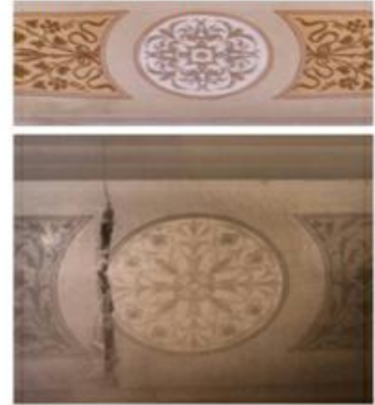
Ilustración 37. Restauración en ventana fachada principal.
