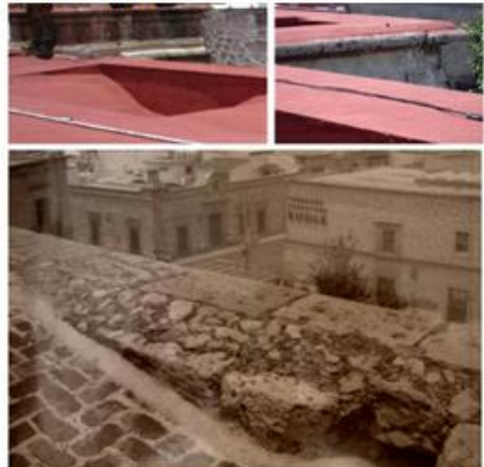
Ilustración 36. Reparación de fractura e impermeabilización en enladrillado de azotea, gárgolas y pretilas.
