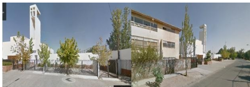
Imagen 1.51 VISTAS EXTERIORES DE LA PARROQUIA DE SANTA MÓNICA
