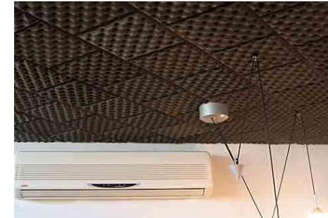
Figura 20. Panel acústico, recuperado de: <http://www.rmig.com>
