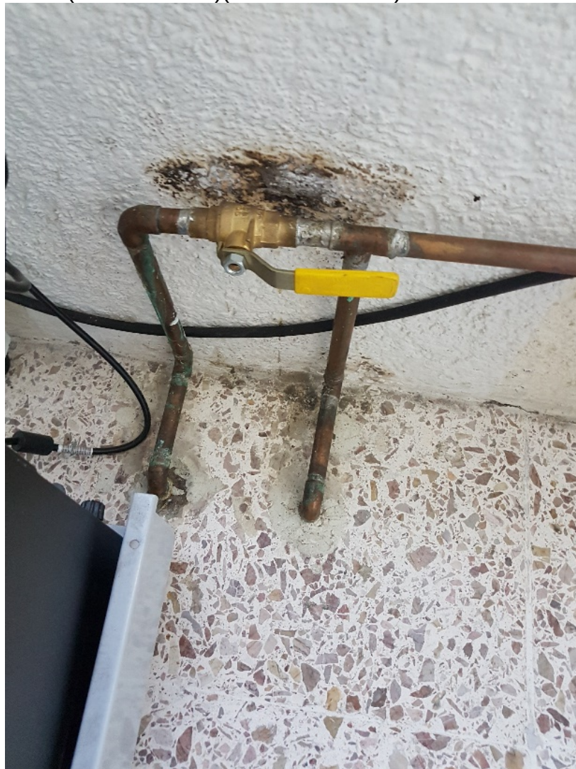
Ilustración 5.1 Paso principal de aire comprimido
