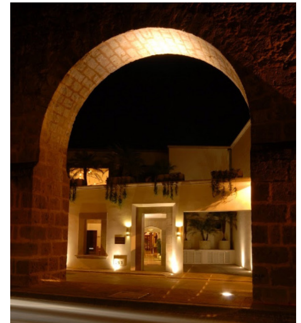
Imagen 8.- Fachada Hotel Casa San Diego
