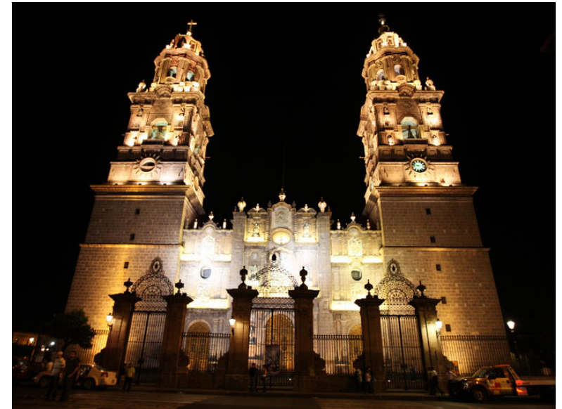
Imagen 5.- Fachada norte de la Catedral de Morelia
