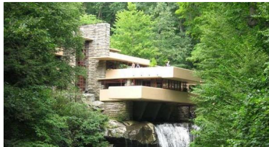
Imagen 46 Fallingwater en Mill Run Pensilvania
