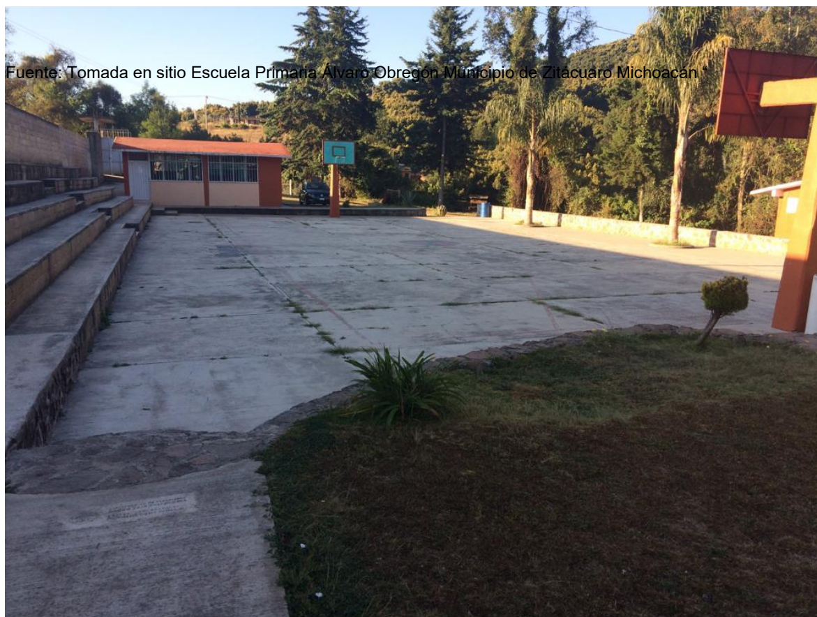
Fotografía 2 Panorámica completa del patio cívico y cancha deportiva
