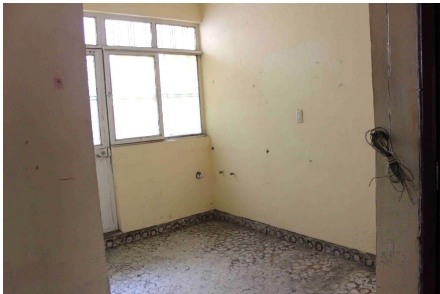
Imagen 3. Estado actual del área cocina.
