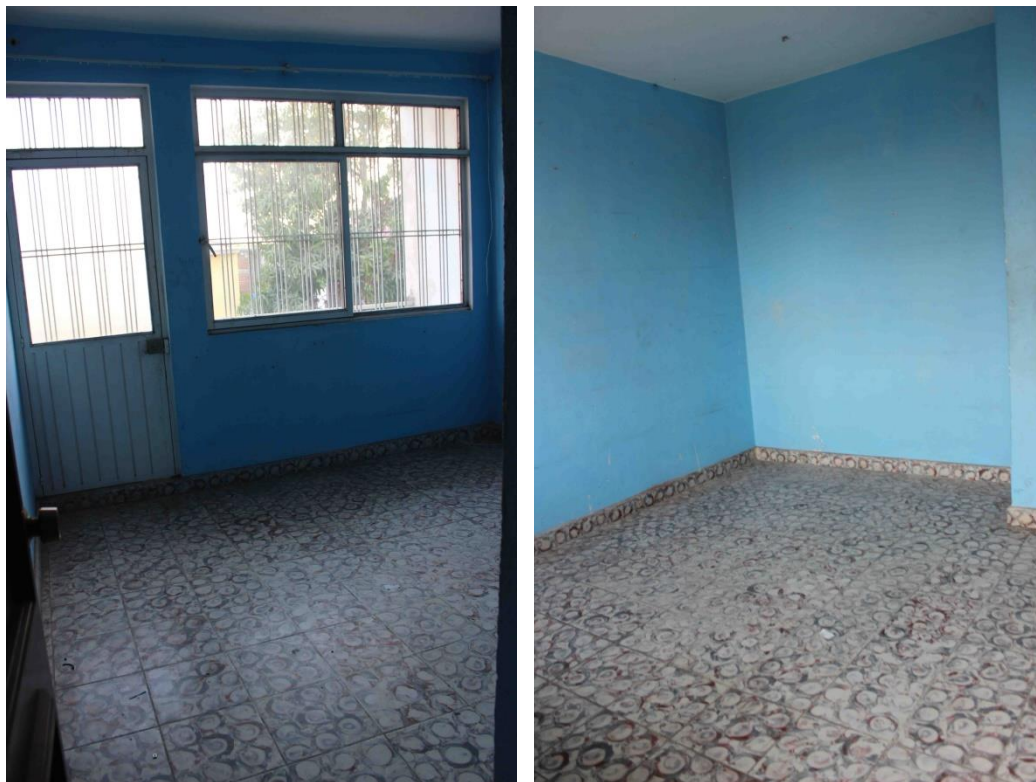
Imagen 8 y 9. Estado actual del área recamara #2.
