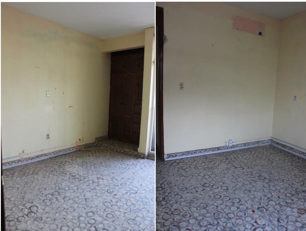
Imagen 6 y 7. Estado actual del área recamara #1.
