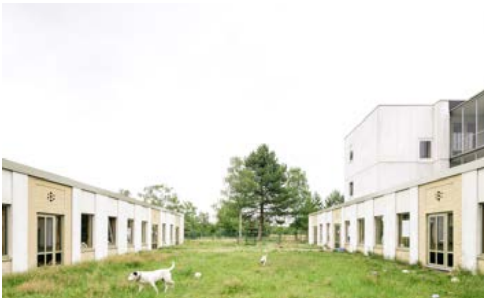
Imagen 35. Refugio de animales y crematorio para mascotas Lommel (Olmo Peeters & Geert Van Hertum, 2021). Recuperado de: https://www.archdaily.com/913538/animal-shelter-and-pet-crematorium-lommel-collectief-noord?ad_source=search&ad_medium=search_result_projects
