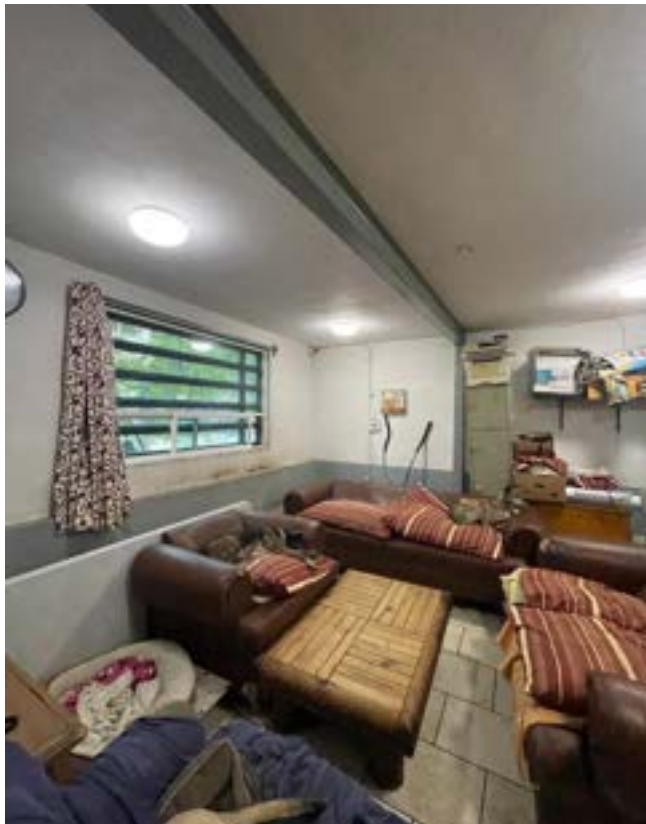
Imagen 40. Estado actual sala. Fotografía de autor, 2023.
