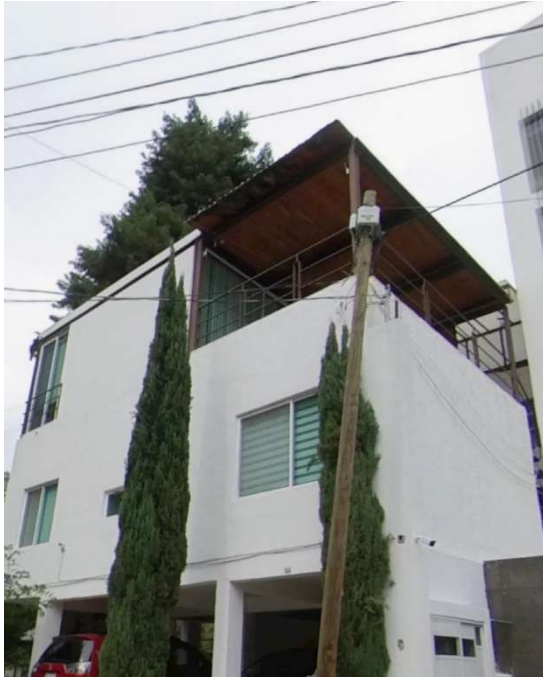
Ilustración 37 Fachada del inmueble en el estado anterior a la intervención, fotografía propia, 2023
