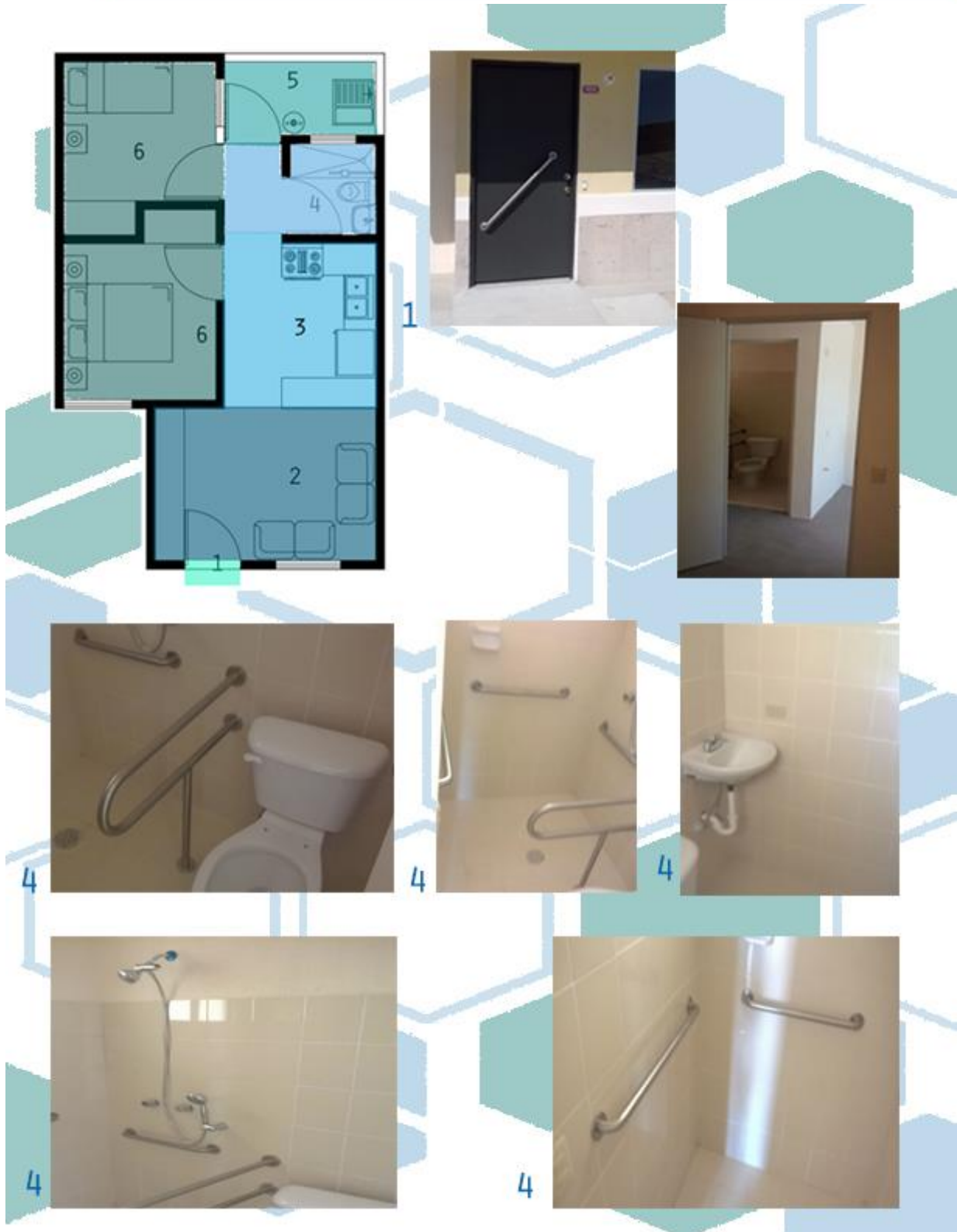
Ilustración 53. BAÑO COMPLETO CON ACCESORIOS, PUERTA EXTERIOR E INTERIORES DE LA VIENDA PARA PERSONA CON DISCAPACIDAD.
