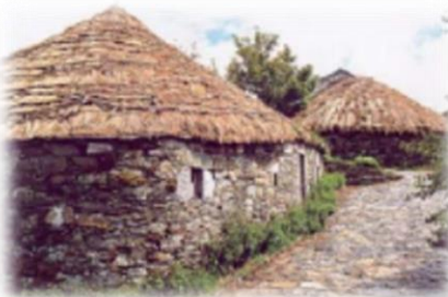
Ilustración 12. PALLOZAS DE LA SIERRA DE LOS ANCARES, CONSTRUCCIÓN TÍPICA DE LA REGIONES DE LEÓN Y ASTURIAS.
