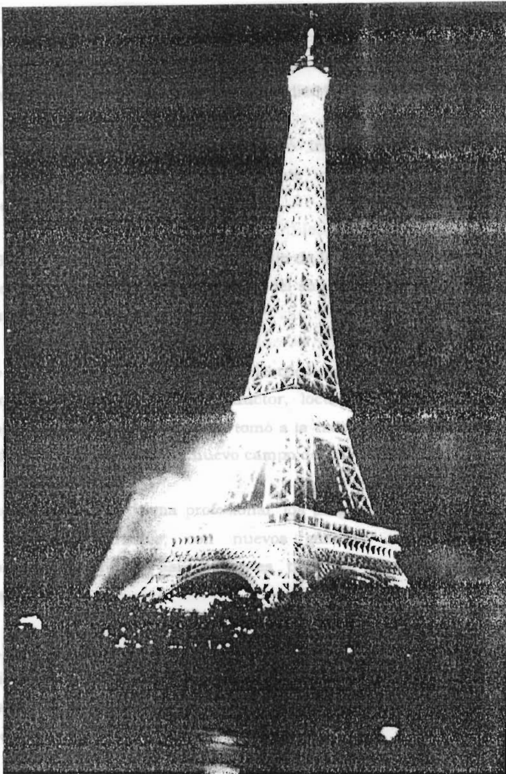
La torre Eiffel, el monumento más característico de París, alcanza los 300 metros de altura. Sus instalaciones son la imagen viva de la historia de la radiodifusión europea. Posee, en la parte superior, una estación de radio y televisión.
