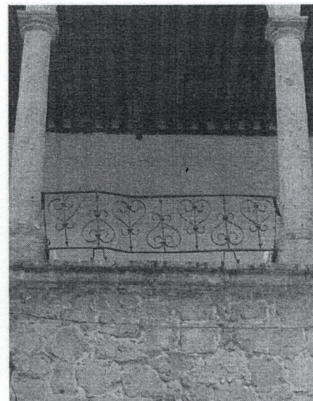
ARCHIVO FOTOGRAFICO OSCAR LOEZA GUERRERO i.25.) Barandal de hierro forjado en la logia.
