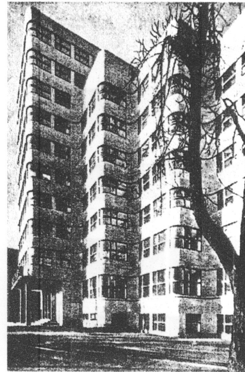
118.- A. Aalto – Turku 1929 Palco para orquesta, construido para el VII centenario de la ciudad. 119.- E. Fahrenkamp – Berlino 1931 – La Shellhaus
