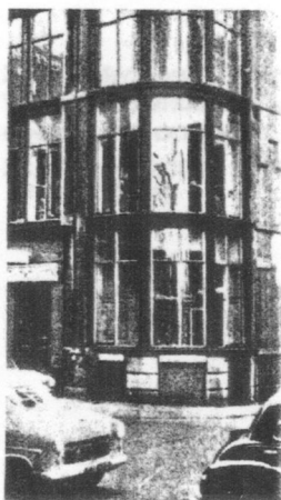
17. P. Ellis - Liverpool - Casa en el n. 16 de Cook Street, 1866 - Vista de la escalera helicoidal con las paredes de cristal.
