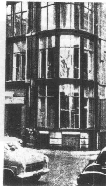
17. P. Ellis - Liverpool - Casa al n. 16 di Cook Street, 1866 - Veduta della scala elicoidale con le pareti di vetro.
