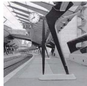
El apoyo vertical que acompaña al apoyo inclinado, es un elemento metálico de sección cambiante que se apoya en un pequeño basamento lineal de hormigón junto con el elemento inclinado.
