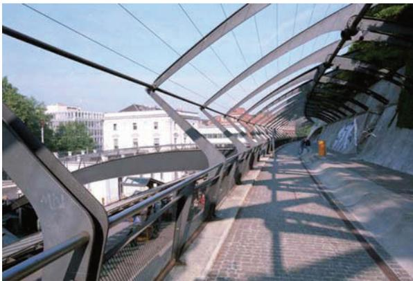
Las armaduras metálicas de la parábola que cubre el paseo reconstruyen con su forma el perfil virtual de la colina haciendo además de escudo protector de ella, cerrando el paso eficazmente, con su combinación de gran voladizo masivo y ancho muro, al ruido del tráfico ferroviario.
