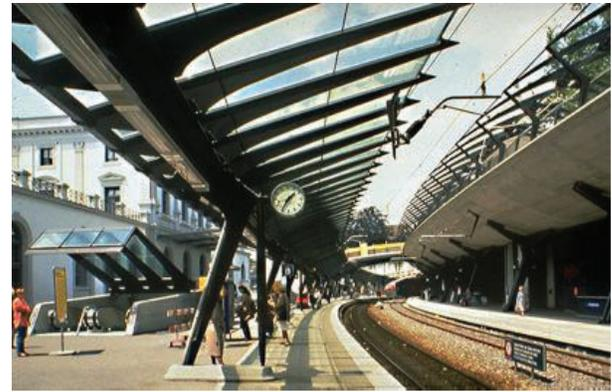
El pergolado en el nivel de los dos primeros andenes, está conformado por 2 elementos metálicos, uno vertical y otro inclinado que sirven de apoyo a una marquesina de vidrio y acero.
