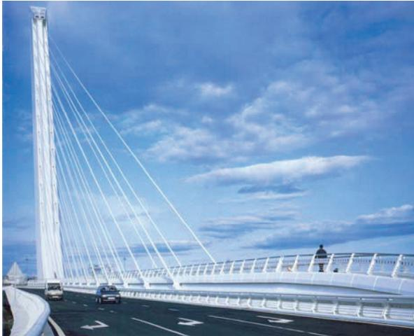
Por lo que respecta al tablero, una viga cajón de sección hexagonal (donde se encuentran los anclajes activos de los tirantes), constituye su columna vertebral: De este cajón parten unas costillas metálicas de sección aligerada, a cada 4 metros, a ambos lados, sobre las que se apoya una losa de hormigón que forma el tablero por donde debe circular el tráfico.
