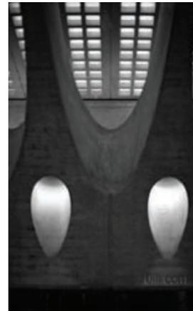
La iluminación natural-cenital es captada a través de pavés, pequeñas perforaciones seriadas con formas geométricas (cuadrados, rectángulo) en los extremos superiores de toda la longitud de la galería, dichas perforaciones geométricas colocadas al nivel de la acera superior, hacen de tapete en los pasillos de los andenes, logrando enlazar los diferentes pasajes subterráneos.
