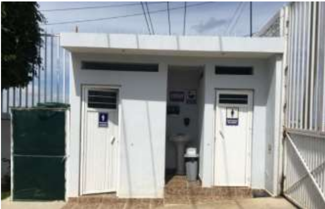
Figura 53. Instalaciones nuevas de sanitarios, hombre y mujer con lavabo. Sección de basureros.
