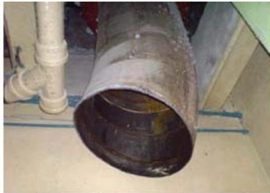
**Figura 14:** Tubo de Descarga de Ropa Sucia
