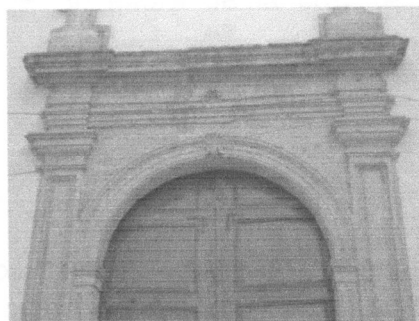
i.22) Detalle de arco de medio punto con extradós moldurado
