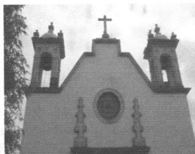
i.24) Detalle de torrecillas, del paramento imafronte piramidal así como de nuevo de la ventana elíptica en la fachada principal
