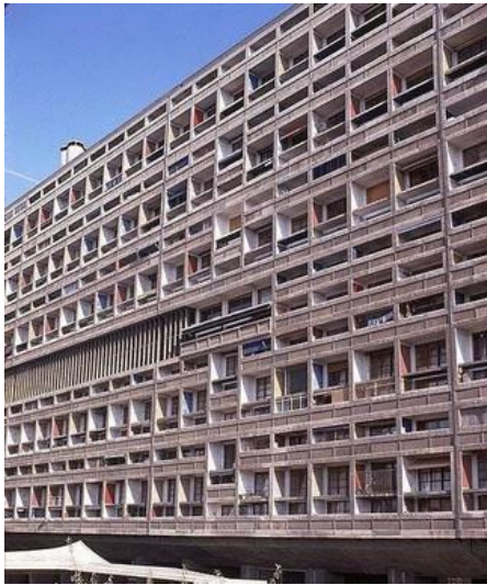
Fig. 19.1 La Unidad Habitacional en Marsella.
