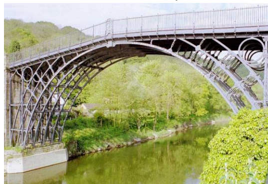
Fig. 17.1 Il Ponte di Coalbrookdale sul fiume Severn.
