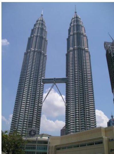
Fig. 21.33 Las Petronas Towers de Kuala Lumpur.
