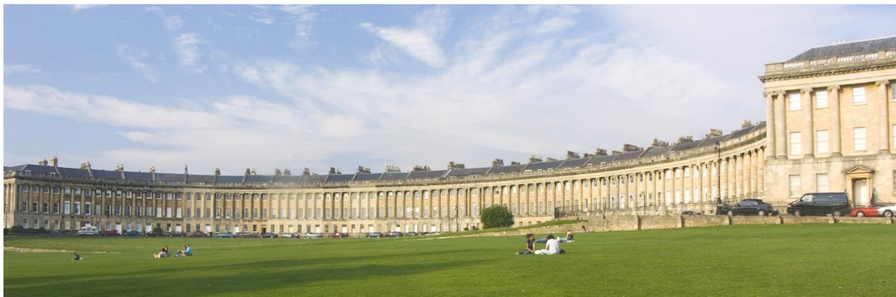
Fig. 16.6 Il Royal Crescent di Bath.
