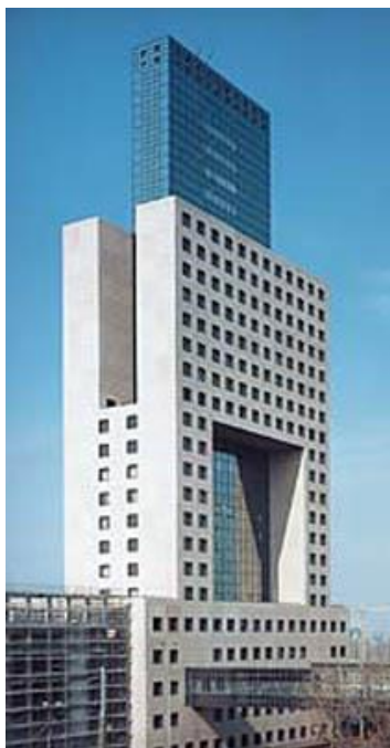
Fig. 20.28 La Gate House della Fiera di Francoforte.
