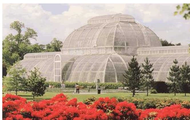
Fig. 17.16 L'architettura delle serre (Derbyshire).
