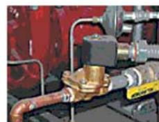
Válvula solenoide para prueba periódica automática, prueba con verdadera baja de presión en la línea.
