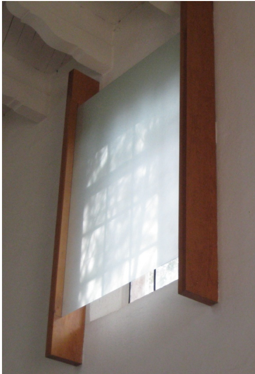
Ventanas de cristal esmerilado que cubren a la ventana original.
