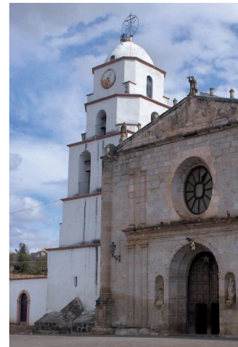
IMG 11: Torre que aloja campanas y reloj
