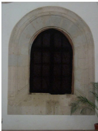
IMG 20: Ventana en refectorio
