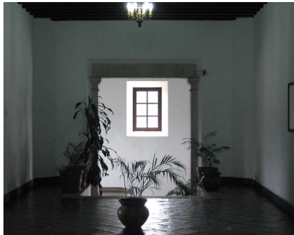
IMG 33: Vista de pasillo en planta alta a entresuelo
