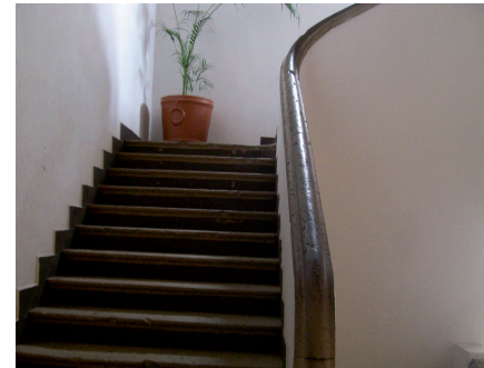
IMG 25: Escalera en Portería
