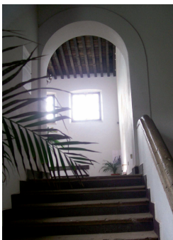
IMG 26: Escalera en Portería con vista al entrepiso
