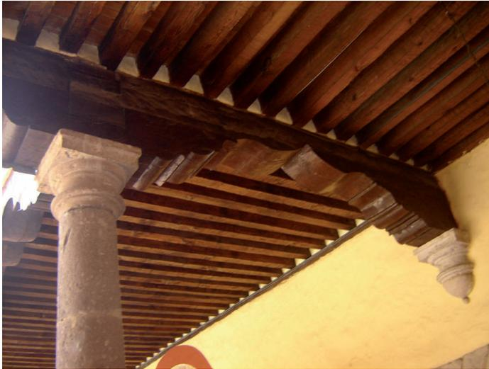
12. Planta baja. Detalle de vigas de madera en techos.
