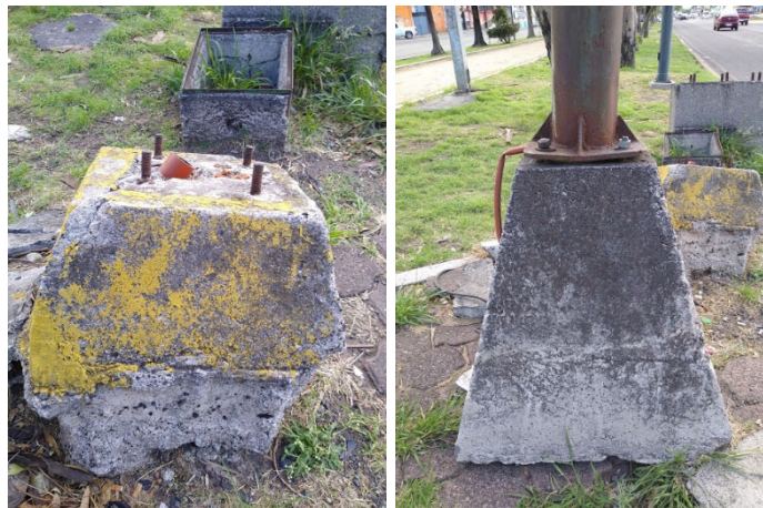
Imagen 21. Sistema de anclaje de luminaria.
