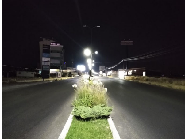
Imagen 31. Ejemplo de alumbrado exterior con LED en vialidades. Fuente: Creación propia.
