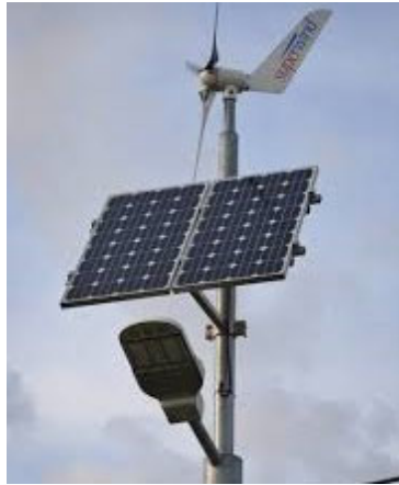
Imagen 26. Equipamiento de luminaria con sistema híbrido. Fuente: Imagen de uso libre de Wikipedia Commons.
