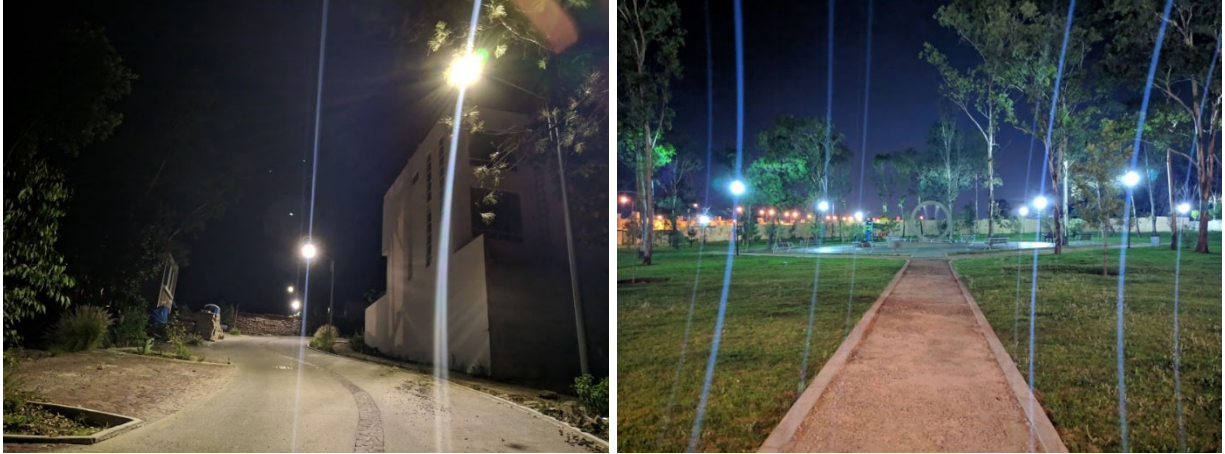
Imagen 29. Ejemplo de alumbrado exterior con LED en conjuntos habitacionales. Fuente: Creación propia.
