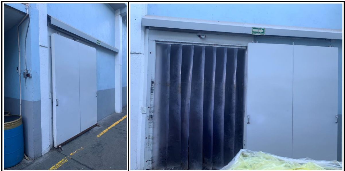
Figura 3. Cámara de refrigeración
