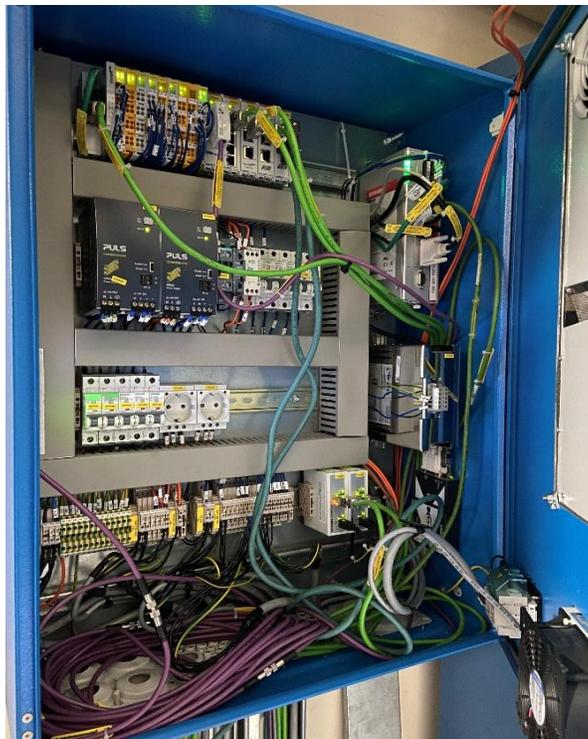
*Ilustración 19 Interior del gabinete principal CBY1. Se ven los cables verdes de comunicación PROFINET y los cables morados para la comunicación con el protocolo CAN Bus.*
