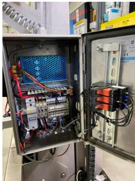
*Ilustración 39 Gabinete con nuevo circuito de control.*
