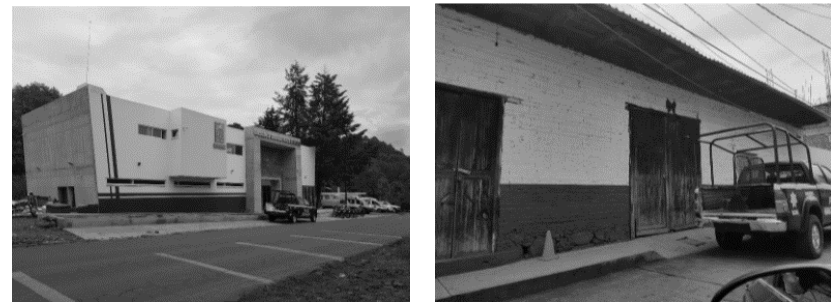
IMAGEN 2: CONDICIONES ACTUALES ESTACIONES DE POLICIA MUNICIPAL TANCÍTARO 2019
