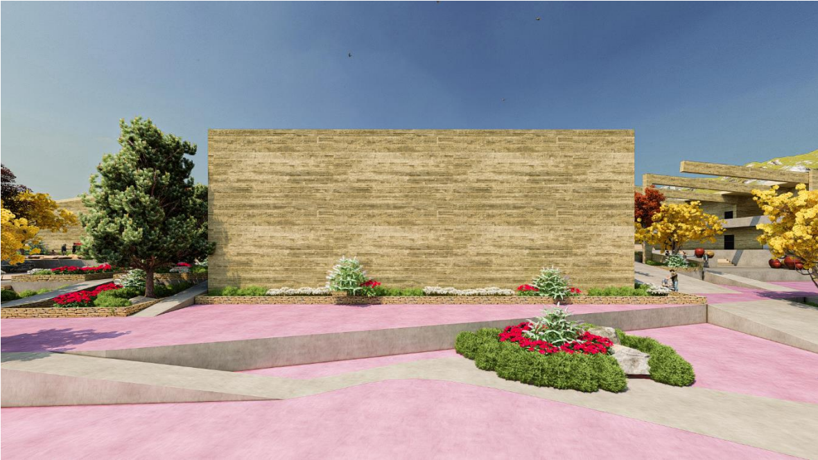
Ilustración 7 Fachada posterior de Nave
