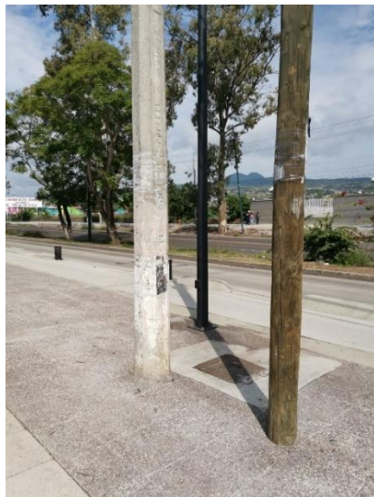
Ilustración 36, Postes de electricidad en terreno, google maps
