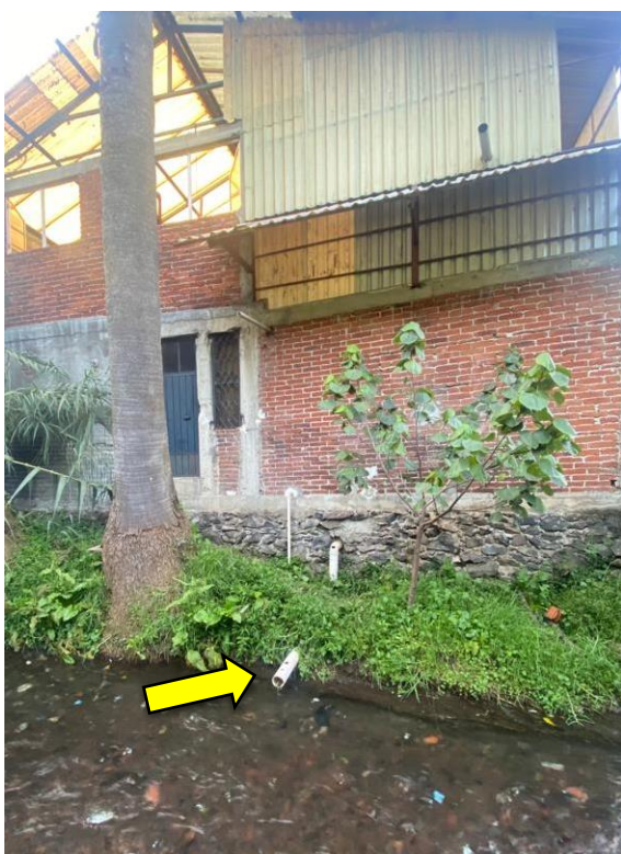
Imagen 7. Contaminación río Los Conejos. Fotografía de elaboración propia
