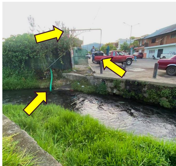
Imagen 9. Contaminación río Los Conejos. Fotografía de elaboración propia
