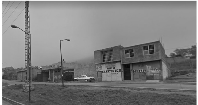
Ilustración 26- Estado actual (fuente: de autor)
