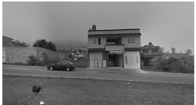
Ilustración 25- Estado actual 2 (fuente: de autor)
