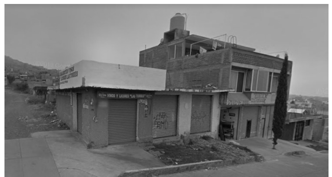
Ilustración 27- Estado actual 3 (fuente: de autor)
