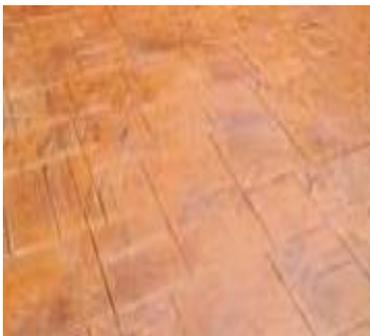
DEFINICIÓN: Concreto estampado color ocre, combinación cemento, agregados pétreos y agua para formar una mezcla moldeable al fraguar forma un elemento rígido y resistente.
