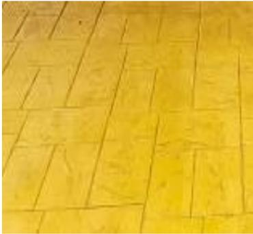
DESCRIPCIÓN: Concreto estampado color amarillo óxido, combinación cemento, agregados pétreos y agua para formar una mezcla moldeable al fraguar forma un elemento rígido y resistente.
