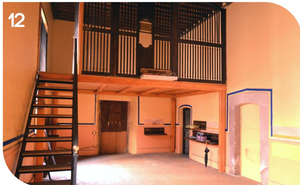
**Habitación Principal:** detalle del Mezzanine ubicado en esta zona. Cuenta con una protección de madera y escaleras de estructura metálica con huellas de madera. Además se pueden observar dos de los accesos clausurados así como el acceso a la zona de bodegas y cocina.
