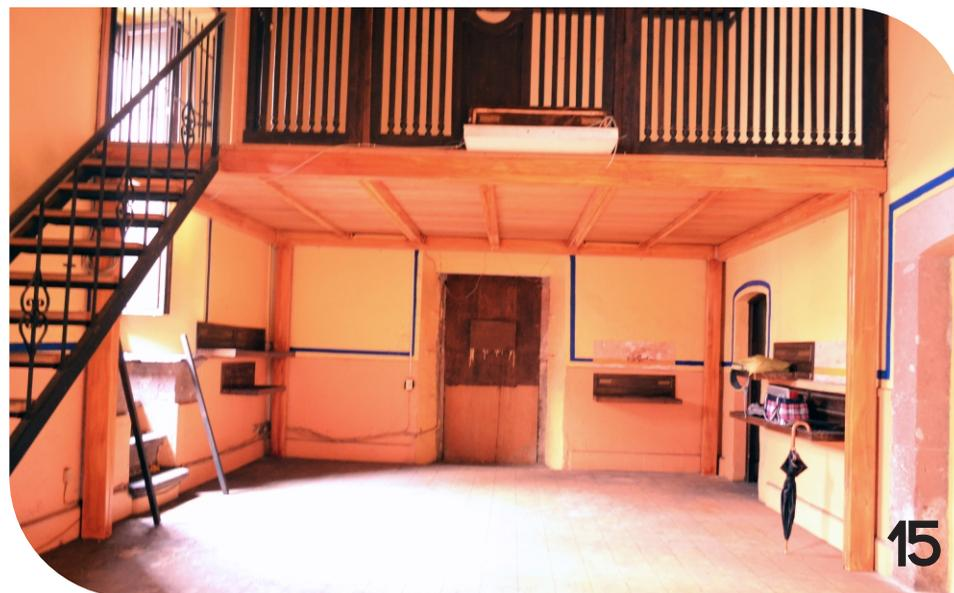
**Habitación Principal:** detalle del Mezzanine ubicado en esta zona. Cuenta con una protección de madera y escaleras de estructura metálica con huellas de madera. Además se pueden observar dos de los accesos clausurados así como el acceso a la zona de bodegas y cocina y uno de los ventanales.
