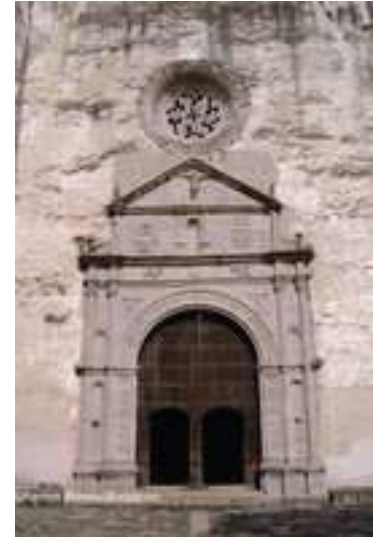
(Fachada del templo de Yecapixtla, con su rosetón a la altura del coro, sus cuatro columnas labradas en cantera y decoraciones en altorrelieve con grutescos)
