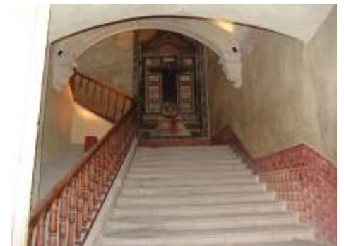
Cubo de escalera
