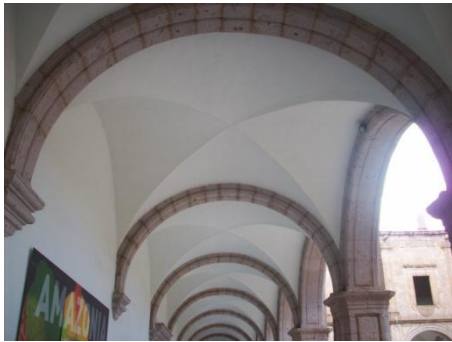
Bóvedas de crucería
