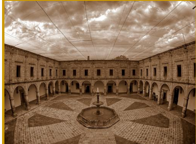
Imagen de Palacio Clavijero en la que se muestra el patio principal del edificio.
