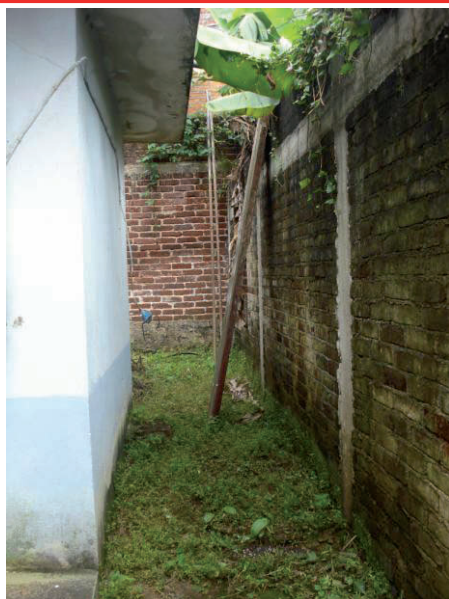
Imagen 26. Vista uno. Parte posterior del edificio existente, colindancia hacia el sur.
