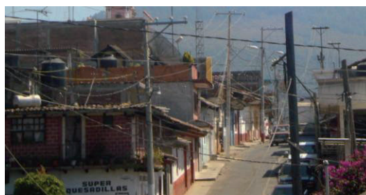
Imagen 15. Ejemplo del cableado aéreo.
