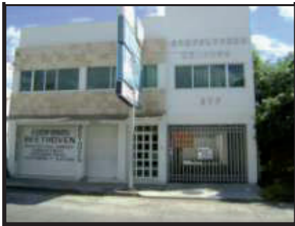
Imagen 59. Fachada del inmueble.
