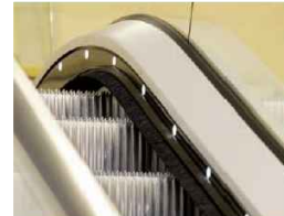
Iluminación por medio de Leds
