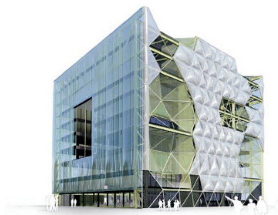
Imagen 141. el Media Tic, muestra el diseño con una membrana como fachada que permite un ahorro energético
