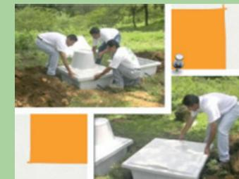
Una vez que los tanques estén enterrados 20 cm al borde del piso. Se coloca a uno de ellos la taza integrada al piso antiderrapante y al segundo la tapa ciega.
