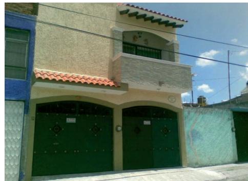
Imagen 19: Fotografía de vivienda cerna a la oficina
