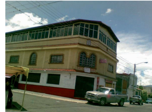
Imagen 20. Fotografía de la construcción de 3 plantas.
