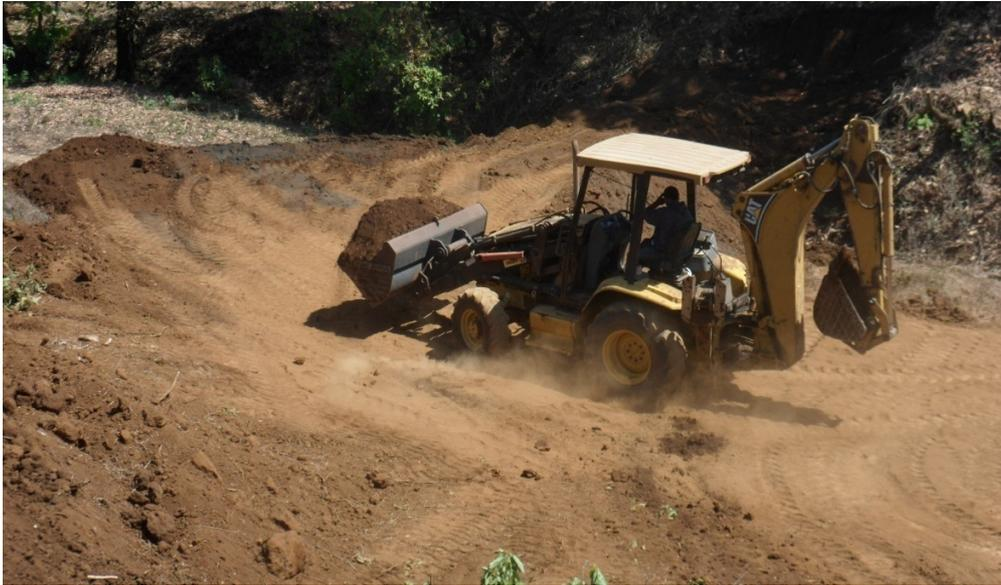
3.- Conformación y afine para la colocación de la membrana (lona de polietileno o PVC): esto le brinda seguridad y protección, protegiéndola de rocas, espinas, ramas y otras irregularidades que podrían dañar la geomembrana.
